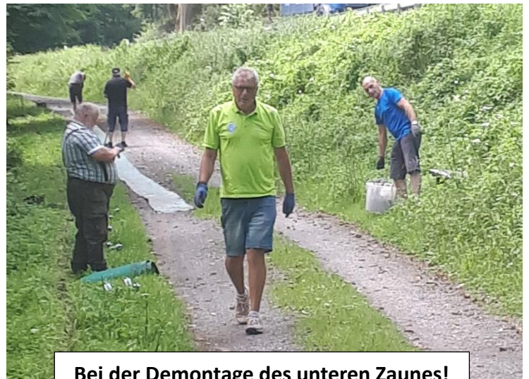
Bei der Demontage des unteren Zaunes!
