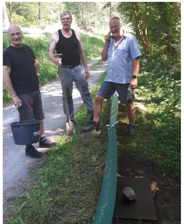
Manfred, Jürgen und Harry beim Einbau der Spezial- Auffangeimer am 26. Juni!
